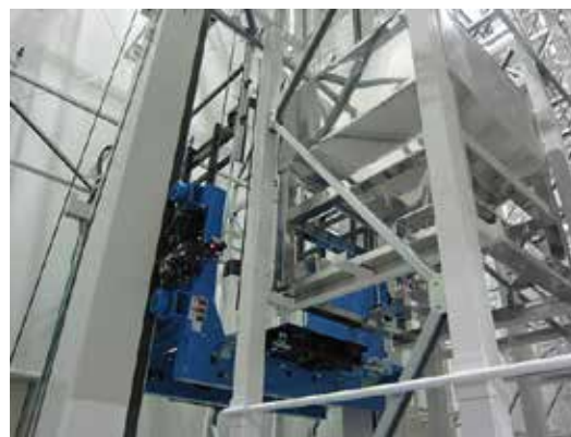
P 立体倉庫 3 (フロービン)
