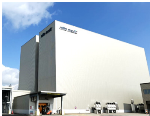
第5 倉庫棟外観
